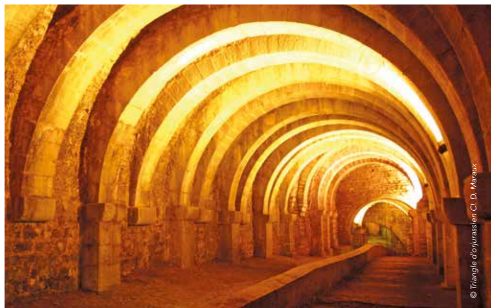
Galerie souterraine de la Grande Saline.
